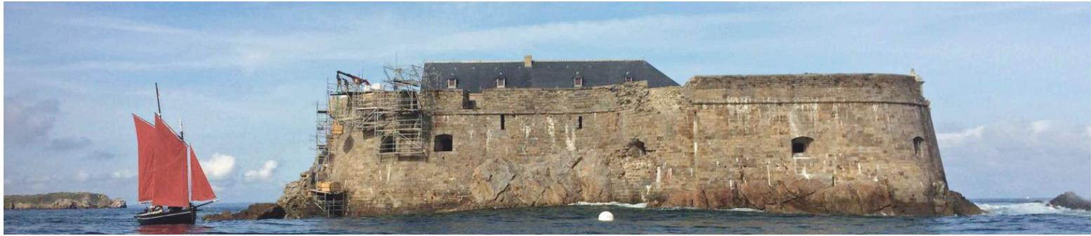
En mai, les maçons de l'entreprise Quélin ont commencé la reconstruction de la partie haute du rempart sud en y incorporant les blocs de granit du culot de l'échauguette. Sur ce culot qui s'élève sur plus de 2,50m, le fût à six pans percés chacun d'une étroite embrasure, que viendra coiffer une élégante coupole surmontée d'un fleuron vers la mi-octobre.
